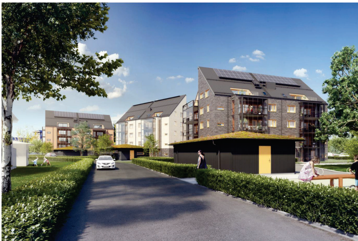
Bild: Uranusvägen, Östra lugnet, Vidingehem
