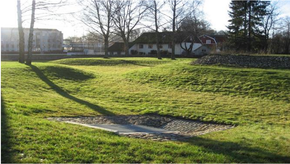
Bild 2: Fördröjningsmagasin för dagvatten vid Skogslyckan.
