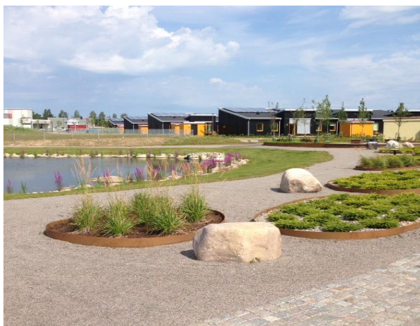
Bild 10: Dagvattenanläggning i parkmiljö Savannen på Vikaholm
